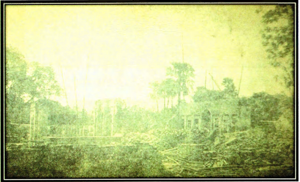
جانب من تدهم بناء دار العلوم الأحمديّة السلفيّة بدرينگه بعد زلزال أصاب المنطقة سنة ١٩٣٤م
